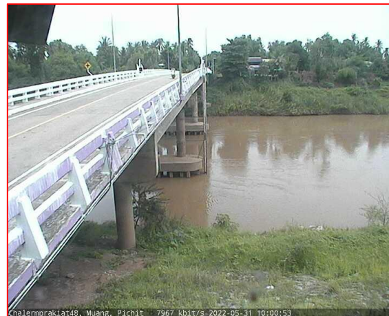
สะพานท่าเสา
