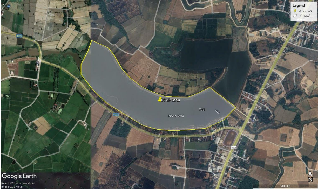
รูปที่ 5.6-3 พื้นที่รับน้ำของบึงพลาบ
