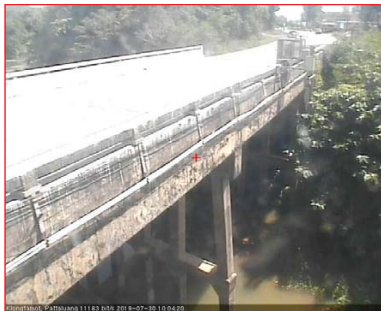
สถานีตะโหมด (ท่าเขียด) - ต.แม่ขรี อ.ตะโหมด จ.พัทลุง (ลุ่มน้ำทะเลสาบสงขลา)
