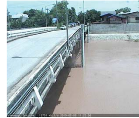
สะพานพระแม่ย่า - อ.เมือง จ.สุโขทัย (ลุ่มน้ำยม)
