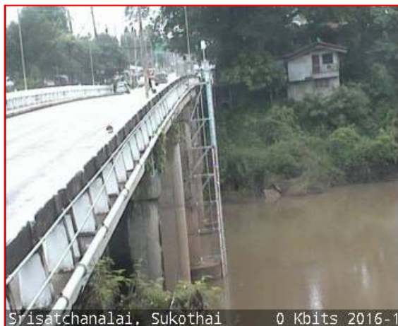
Srisatchanalai, Sukothai 0 Kbits 2016-1 สถานีสะพานศรีสัชชนาลัย อ.ศรีสัชชนาลัย จ.สุโขทัย (ลุ่มน้ำยม)
