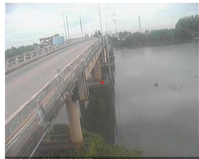
สะพานข้ามแม่น้ำท่าจีน 3 - อ.เมือง จ.สมุทรสาคร (ลุ่มน้ำท่าจีน)
