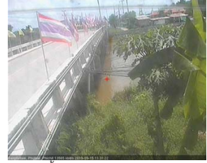
สะพานบ้านโพทะเล - อ.โพทะเล จ.พิจิตร (ลุ่มน้ำยม)
