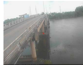
สะพานข้ามแม่น้ำท่าจีน 3 - อ.เมือง จ.สมุทรสาคร (ลุ่มน้ำท่าจีน)
