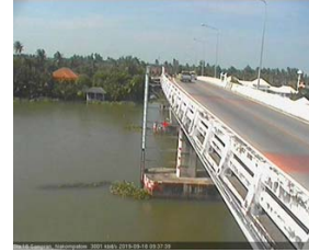
สะพานบุญรัตนประชาภูวรัตน์ - อ.สามพราน จ.นครปฐม (ลุ่มน้ำท่าจีน)
