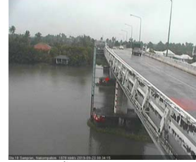
สะพานบุญรัตนประชาวันรัตน์ - อ.สามพราน จ.นครปฐม (ลุ่มน้ำท่าจีน)
