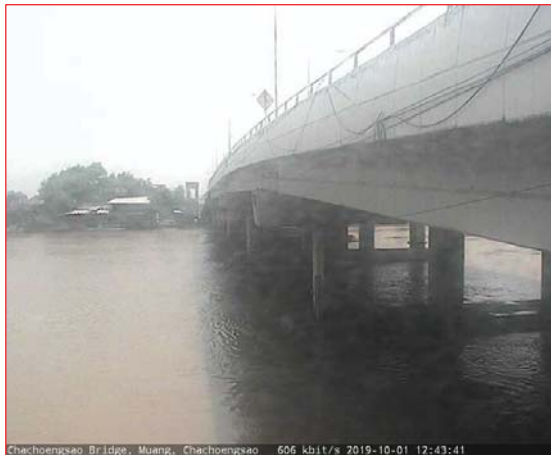
สถานีเชิงสะพานจะเข็งเทรา ต.หน้าเมือง อ.เมือง จ.ฉะเชิงเทรา (ลุ่มน้ำบางปะกง – แม่น้ำบางปะกง)
