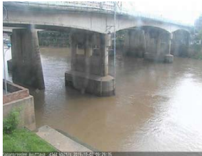
สะพานปรีดี - อ.เมือง จ.พระนครศรีอยุธยา (ลุ่มน้ำเจ้าพระยา)
