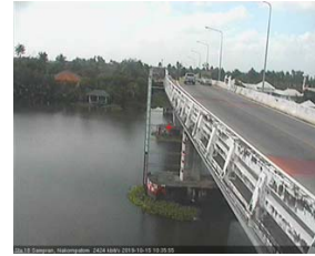
สะพานบุญรัตนประชาอนุวัฒน์ - อ.สามพราน จ.นครปฐม (ลุ่มน้ำท่าจีน)
