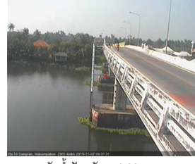
สะพานบุญรัตน์ประชาชนูวัฒน์ - อ.สามพราน จ.นครปฐม (ลุ่มน้ำท่าจีน)
