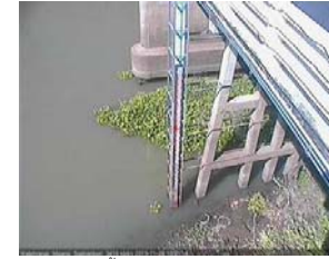
สะพานวัดพระรูป อ.เมือง จ.สุพรรณบุรี (ลุ่มน้ำท่าจีน)
