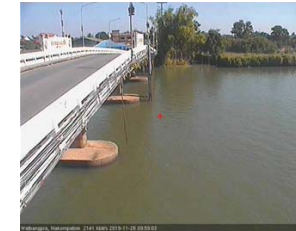
สะพานหลวงพ่เป็น - อ.นครชัยศรี จ.นครปฐม (ลุ่มน้ำท่าจีน)
