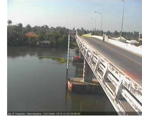
สะพานบุญรัตนประชาภูวรัตน์ - อ.สามพราน จ.นครปฐม (ลุ่มน้ำท่าจีน)
