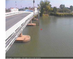
สะพานหลวงพ่เป็น - อ.นครชัยศรี จ.นครปฐม (ลุ่มน้ำท่าจีน)
