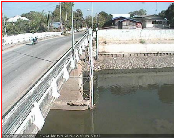
สถานีสะพานพระแม่ย่า อ.เมือง จ.สุโขทัย (ลุ่มน้ำยม)
