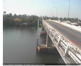
สะพานบุญรัตน์ประชาชนูวัฒน์ - อ.สามพราน จ.นครปฐม (ลุ่มน้ำท่าจีน)
