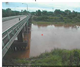
สะพานท่าเสา - อ.เมือง จ.อุตรดิตถ์ (ลุ่มน้ำ่าน)
