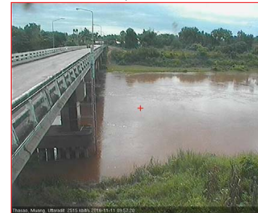
สถานีสะพานท่าเสา อ.เมือง จ.อุตรดิตถ์ (ลุ่มน่าน)
