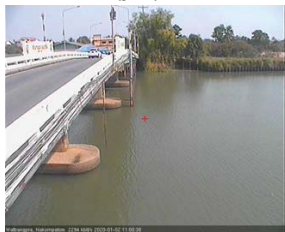
สะพานหลวงพ่อบึง - อ.นครไชยศรี จ.นครปฐม (ลุ่มน้ำท่าจีน)
