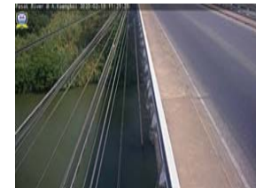
สถานีแม่น้ำป่าสัก - อ.แก่งคอย จ.สระบุรี (ลุ่มน้ำปิง-วัง-สะแกกรัง-ป่าสัก)
