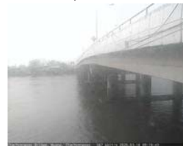
เขื่อนสะพานฉะเชิงเทรา - อ.เมือง จ.ฉะเชิงเทรา (ลุ่มน้ำบางปะกง)
