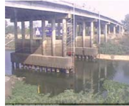
สลัก - อ.สติก จ.บุรีรัมย์ (ลุ่มน้ำมูล)
