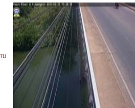
สถานีแม่น้ำป่าสัก - อ.แก่งคอย จ.สระบุรี (ลุ่มน้ำปิง-วัง-สะแกกรัง-ป่าสัก)
