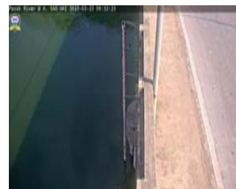
สถานีแม่น้ำป่าสัก - อ.เสนาหือ จ.สระบุรี (ลุ่มน้ำปิง-วัง-สะแกกรัง-ป่าสัก)
