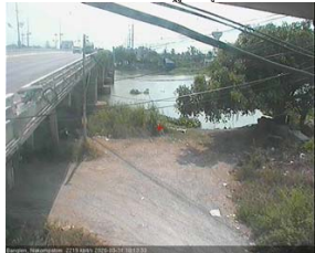
สะพานข้ามแม่น้ำท่าจีน ทางหลวง๓๔๖ อ.บาเลน จ.นครปฐม (ลุ่มน้ำท่าจีน)
