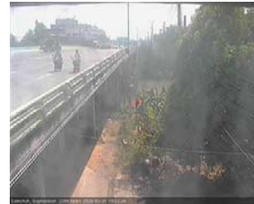
สะพานข้ามแม่น้ำท่าจีน ทางหลวง๓๒๖๔ อ.สามชุก จ.สุพรรณบุรี (ลุ่มน้ำท่าจีน)
