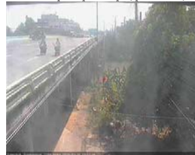
สะพานข้ามแม่น้ำท่าจีน ทางหลวง๓๒๖๕ อ.สามชุก จ.สุพรรณบุรี (ลุ่มน้ำท่าจีน)
