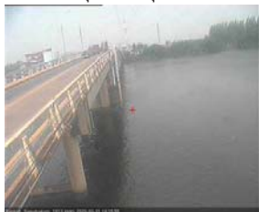
สะพานข้ามแม่น้ำท่าจีน ๓ - อ.เมือง จ.สมุทรสาคร (ลุ่มน้ำท่าจีน)
