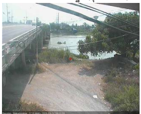
สะพานข้ามแม่น้ำท่าจีน ทางหลวง๓๔๖ อ.บางเลน จ.นครปฐม (ลุ่มน้ำท่าจีน)
