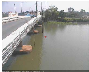
สะพานหลวงพ่อบึง - อ.นครไชยศรี จ.นครปฐม (ลุ่มน้ำท่าจีน)
