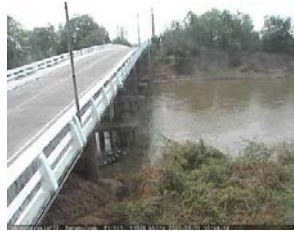
สะพานเฉลิมพระเกียรติ ร.9 2 พระราชมูลสถาน จ.พิจิตร (ลุ่มน้ำน่าน)
