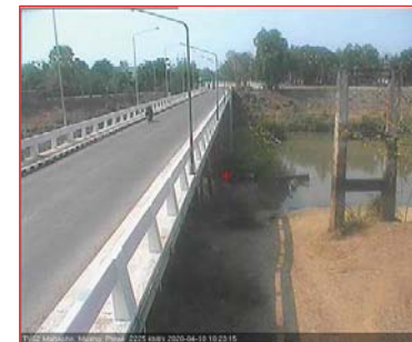
สถานีสะพานมหาไพรี อ.เมือง จ.แพร่ (ลุ่มน้ำยม)
