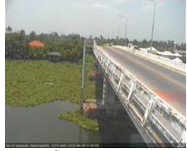
สะพานบุญรัตน์ประชานุวัฒน์ - อ.สามพราน จ.นครปฐม (ลุ่มน้ำท่าจีน)
