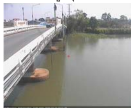
สะพานหลวงพ่อเปิ่น - อ.นครไชยศรี จ.นครปฐม (ลุ่มน้ำท่าจีน)
