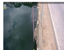
สถานีแม่น้ำป่าสัก - อ.เสนาหือ จ.สระบุรี (ลุ่มน้ำปิง-วัง-สะแกกรัง-ป่าสัก)
