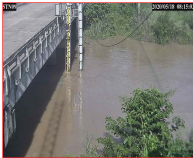
สถานีบ้านม่วงก้อง - คลองหาลำปึง อ.สะเตกา จ.สงขลา กรมชลประทาน : (ลุ่มน้ำทะเลสาบสงขลา)
