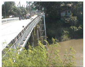
สะพานศรีล้าขลล - อ.ศรีล้าขลล จ.สุโขทัย (ลุ่มน้ำยม)
