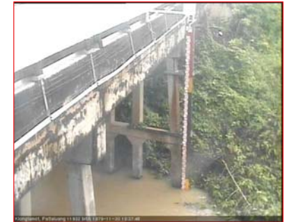
สถานีคลองตะโหมด - ต.แม่ขรี อ.ตะโหมด จ.พัทลุง (ลุ่มน้ำทะเลสาบสงขลา)
