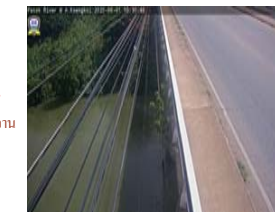
สถานีแม่น้ำป่าสัก - อ.แก่งคอย จ.สระบุรี (ลุ่มน้ำปิง-วัง-สะแกกรัง-ป่าสัก)
