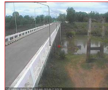
สถานีสะพานมหาไพ้อี อ.เมือง จ.แพร่ (ลุ่มน้ำยม)
