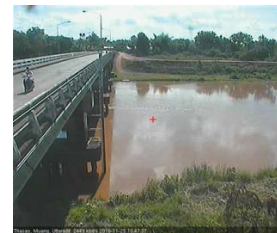
สะพานท่าเสา - อ.เมือง จ.อุตรดิตถ์ (ลุ่มน้ำน่าน)
