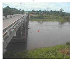
สะพานท่าเสา - อ.เมือง จ.อุตรดิตถ์ (ลุ่มน้ำน่าน)
