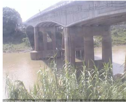
เชิงสะพานสิงห์บุรี - อ.เมือง จ.สิงห์บุรี (ลุ่มน้ำเจ้าพระยา)
