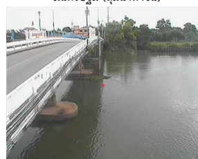
สะพานหลวงพ่เป็น - อ.นครไชยศรี จ.นครปฐม (ลุ่มน้ำท่าจีน)
