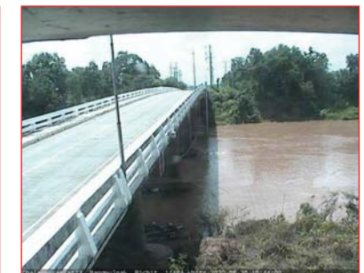
สถานีสะพานเฉลิมพระเกียรติ อ.บางมูลนาก จ.น่าน (ลุ่มน้ำน่าน)
