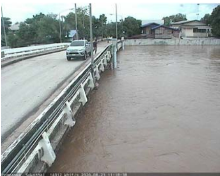
สะพานพระเมรุมา - อ.เมือง จ.สุโขทัย (ลุ่มน้ำยม)
