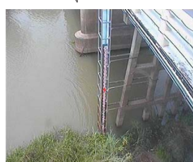
สะพานวัดพระรูป อ.เมือง จ.สุพรรณบุรี (ลุ่มน้ำท่าจีน)
