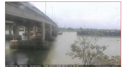
สถานีบ้านท้ายดง ด.บางกระบือ อ.สามโคก จ.ปทุมธานี (ลุ่มน้ำเจ้าพระยา)
