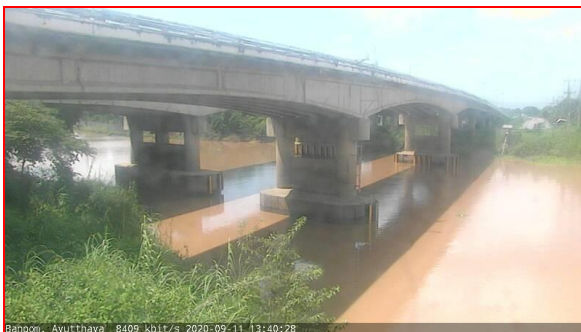
สถานีบ้านป้อม ต.บ้านป้อม จ.พระนครศรีอยุธยา (ลุ่มน้ำเจ้าพระยา)
