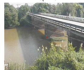
บ้านเหล่านกขุม - อ.เมือง จ.ขอนแก่น (ลุ่มน้ำชี)
