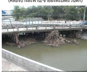
ร.รอนุบาลบางสะพาน - อ.บางสะพาน จ.ประจวบคีรีขันธ์ (คลองบางสะพาน/ชายฝั่งทะเลตะวันตก)
