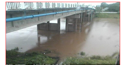
สถานีศาลากลางอ่างทอง ต.บางแก้ว อ.เมือง จ.อ่างทอง (ลุ่มน้ำเจ้าพระยา)
