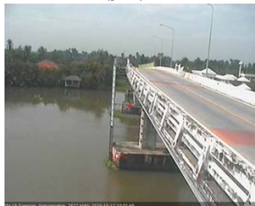
สะพานบุญรัตน์ประชาวุฒินัน - อ.สามพราน จ.นครปฐม (ลุ่มน้ำท่าจีน)
