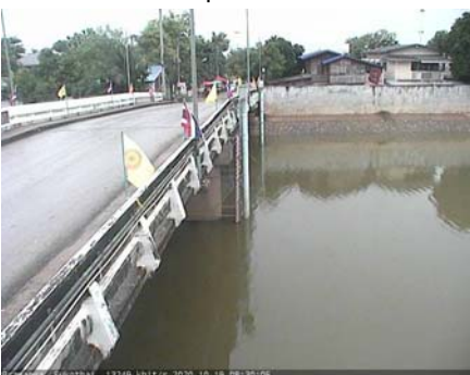
สะพานพระแม่ย่า - อ.เมือง จ.สุโขทัย (ลุ่มน้ำยม)
